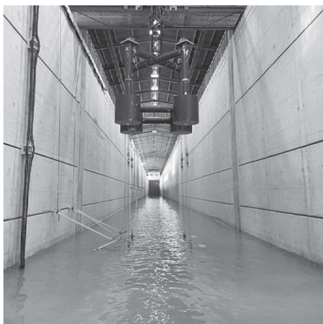
Abb. 7: Foto des gesamten Systems in seiner Einbauposition vor dem Befüllen des Kanals mit Blick auf die Wellenmaschine. (Abbildung entnommen aus [13]).
